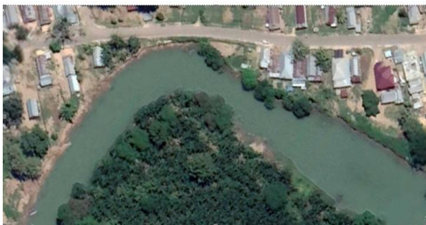
Gambar 5 Gerusan Pada Tebing Sungai Wae Mese mengancam kestabilan jalan nasional
