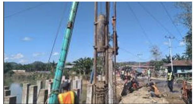
Gambar 7 Proses Pemasangan Tiang Pancang Beton Tebing Sungai Wae Mese
