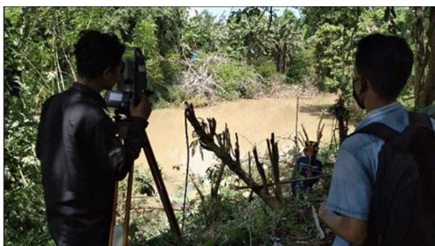
Gambar 2. Pengukuran awal penentuan titik pelaksanaan pekerjaan
