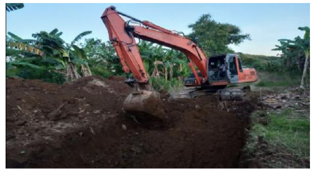
Gambar 3. Galian tanah pondasi parapet pemasangan batu kali
