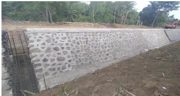
Gambar 4 Parapet pasangan batu dengan dilatasi Beton K175
