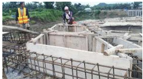
Gambar 8 Proses Pemasangan Pilecap Tiang Pancang Beton Tebing Sungai Wae Mese
