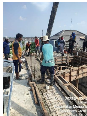
Gambar. 2. Pekerjaan Pengecoran
