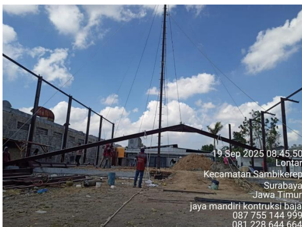
Gambar 7. Foto Proses Menaikkan Rafter
