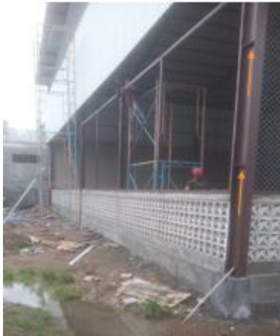
Gambar 15. Penambahan Plat Stiffner di kolom Depan dengan jarak antar plat 150 cm
