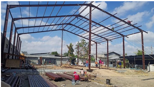
Gambar 16. Penambahan Plat Stiffner di kolom dan Rafter dengan jarak antar plat 150 cm
