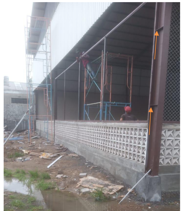
Gambar 15. Penambahan Plat Stiffener di kolom Depan dengan jarak antar plat 150 cm
