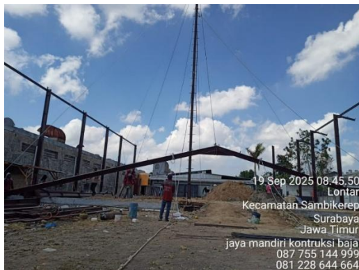
Gambar 7. Foto Proses Menaikkan Rafter
