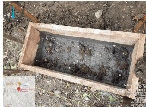
Gambar. 5. Bekisting cor untuk kaki mounting panel surya
