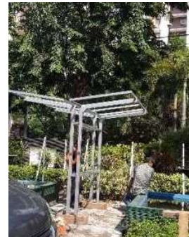
Gambar. 7. Kerangka besi hollow untuk penyangga panel surya
