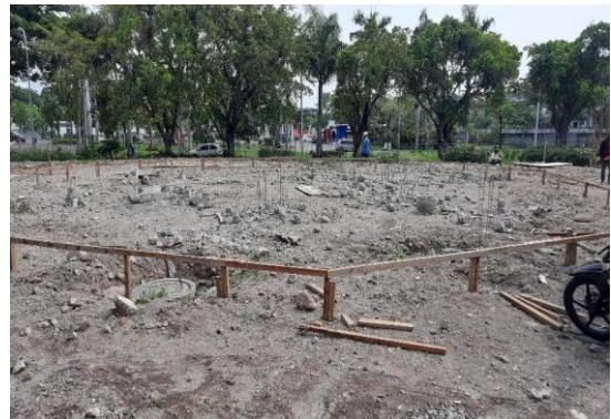
Gambar 4. Pembuatan Bouwplank Area Pagoda Chinatown Park Shanghai
