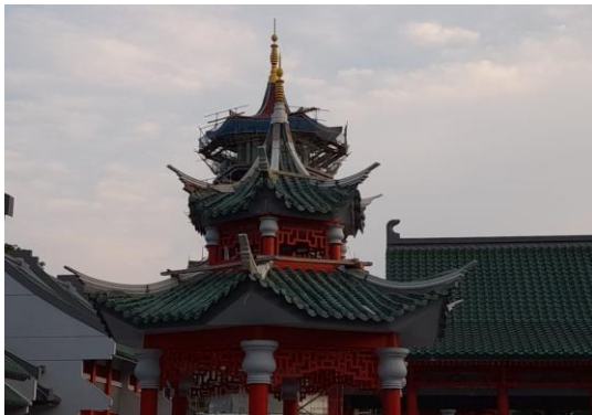
Gambar 9. Pemasangan Ornamen Stupa dan Railing
