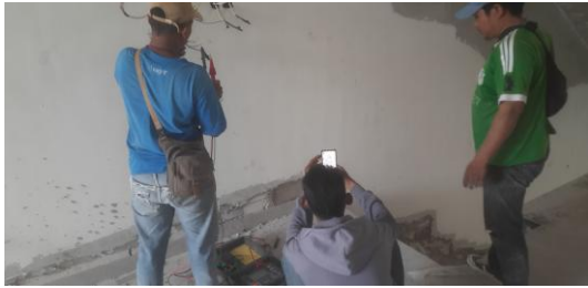
Gambar 8. Pengujian Grounding dari instalasi Elektrikal
