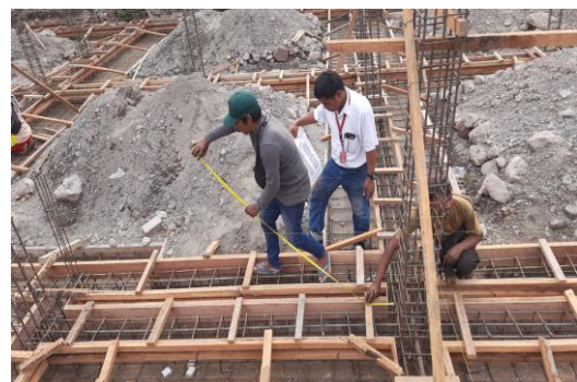
Gambar 5. Supervisi Pembesian Sloof dan Pile Cap Chinatown Park Shanghai
