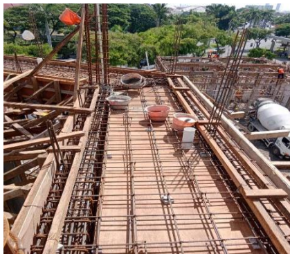
Gambar 7. Supervisi Pembesian Plat dan Balok
