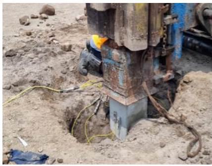
Gambar 6. PDA Test Tiang Pancang 20x20
