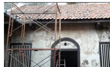
Gambar 17. Kondisi Genteng Setelah Restorasi Sumber: Pribadi, 2024
