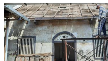
Gambar 16. Kondisi Struktur Atap Setelah Restorasi Sumber: Pribadi, 2024
