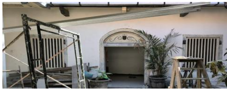
Gambar 11. Kondisi Cat Dinding Setelah Restorasi Sumber: Christine, 2024
