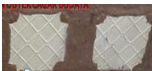
Gambar 20. Kondisi Plafon Setelah Restorasi Sumber: Christine, 2024
