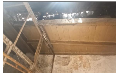
Gambar 15. Kondisi Pelapukan Struktur Atap Sumber: Christine, 2024
