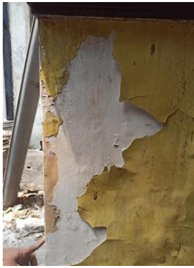
Gambar 9. Kondisi Cat Dinding Sebelum Restorasi Sumber: Christine, 2024
