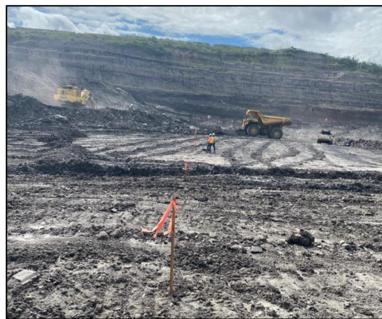
Gambar 9. Pemasangan Patok Acuan Survei di Lapangan
