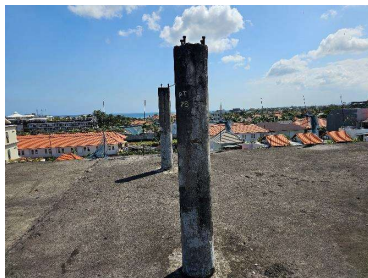
Gambar 15. Bagian kolom rooftop yang mengalami pelapukan
