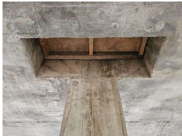
Gambar 14. Retak geser pons pada koneksi pelat dan kolom
