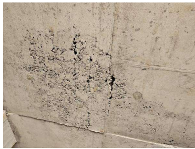
Gambar 13. Kondisi permukaan pelat karena kurangnya pemadatan
