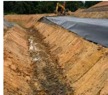
Gambar 4. Pembentukan saluran inlet dengan opsi saluran terbuka
