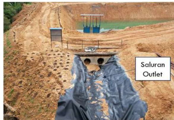
Gambar 6. Pembentukan saluran outlet dengan opsi saluran terbuka
