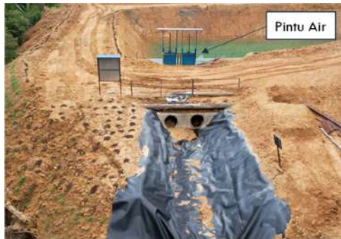
Gambar 5. Pembentukan pintu air ( steel pipe culvert )
