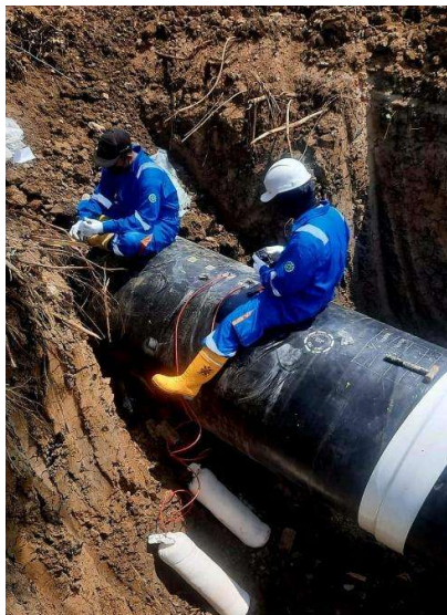
Gambar 5. Pemasangan Anoda di lapangan
