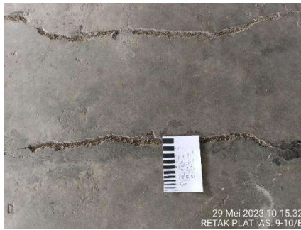
Gambar 7. Dokumentasi Retak Pelat Lantai terhadap Balok
