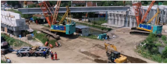
Gambar. 15. Setting Girder pada posisi bearing pad
