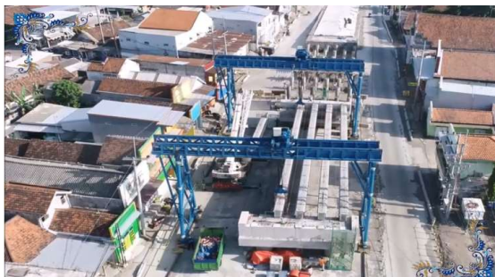
Gambar. 3. Erection Girder Menggunakan Portal Gantry
