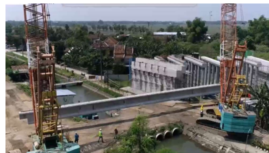
Gambar. 14. Erection Girder Menggunakan Launcher
