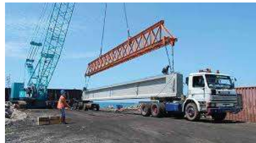
Gambar. 4. Erection Girder Menggunakan 1 Crane
