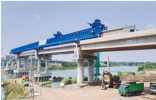
Gambar. 6. Erection Girder Menggunakan Launcher
