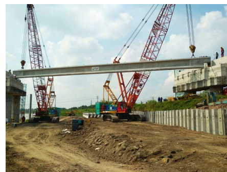
Gambar. 5. Erection Girder Menggunakan 2 Crane
