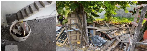
Gambar. 3. Peletakkan waste yang tidak membahayakan pekerja (Sumber: Dokumentasi pribadi)
