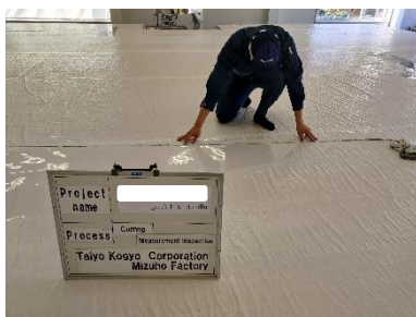
Gambar 7. Proses Fabrikasi ETFE: (a) Pemotongan dan Inspeksi Pengukuran dan (b) Pemotongan ETFE (sumber: Taiyo Kogyo Corporation)
